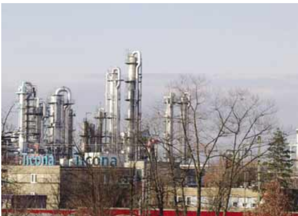
In der Einflugschneise: Das Kelsterbacher Chemiewerk Ticona müsste beim Bau einer Nordwestbahn teilweise abgerissen werden.
